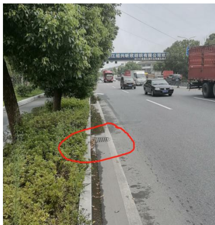
图 8.2-2 道路两侧截流沟、边沟
