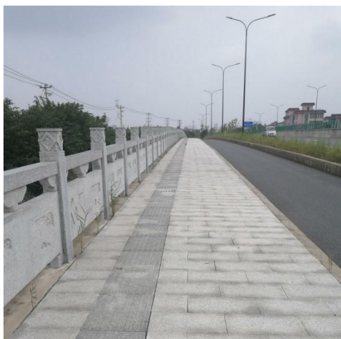
图 8.2-3 桥梁处路面形式
